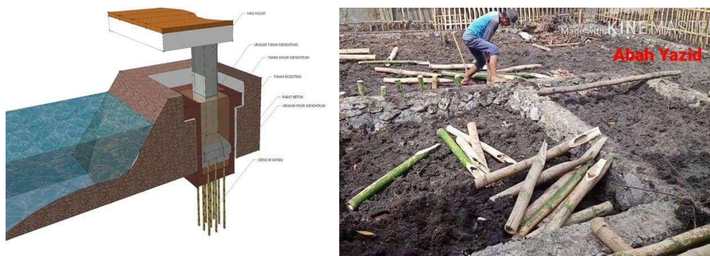
Gambar 4. Cerucuk bambu dan penancangannya
