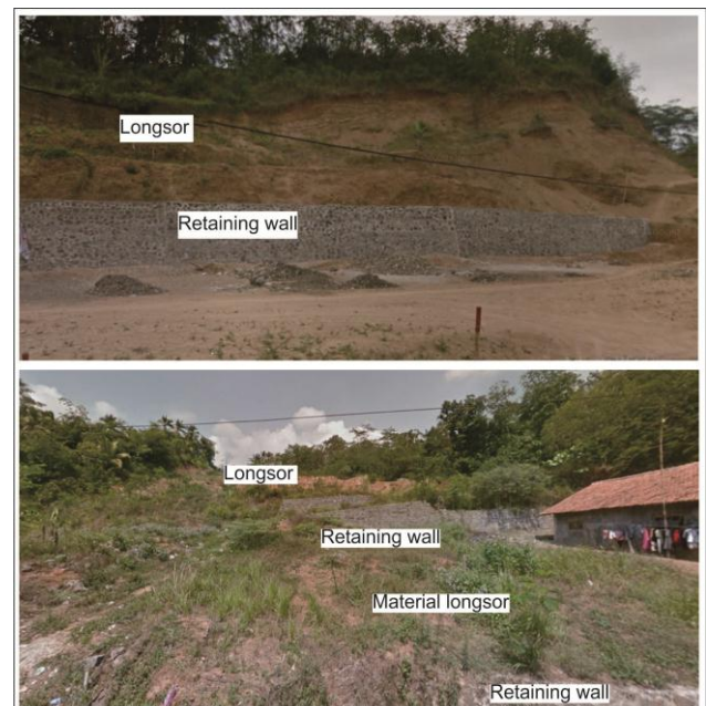
Gambar 4. Penanggulangan longsor dengan metode retaining wall.
