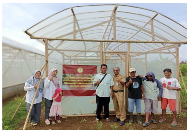
Gambar 2. Bangunan Green House di lahan Poktan
