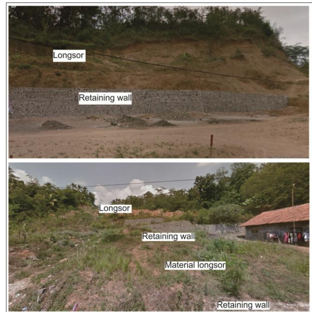
Gambar 4. Penanggulangan longsor dengan metode retaining wall.
