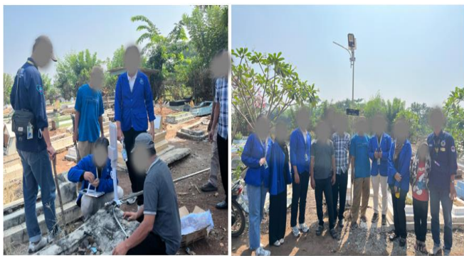
Gambar 3 Perakitan dan pemasangan instalasi PLTS di lokasi TPU
