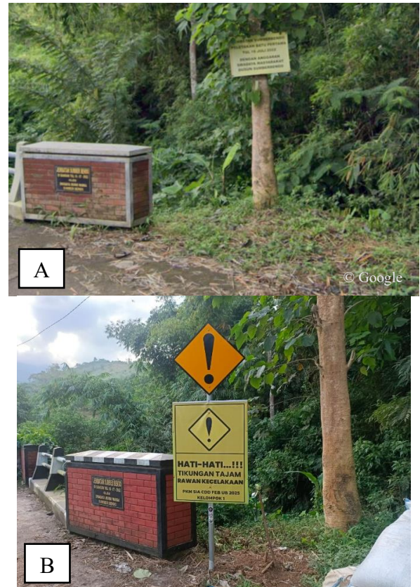
Gambar 4. Perbandingan Kondisi Lokasi Pemasangan Rambu-Rambu Reflektif Sebelum Pemasangan Rambu-Rambu Reflektif (A) dan Sesudah Pemasangan Rambu-Rambu Reflektif (B)
