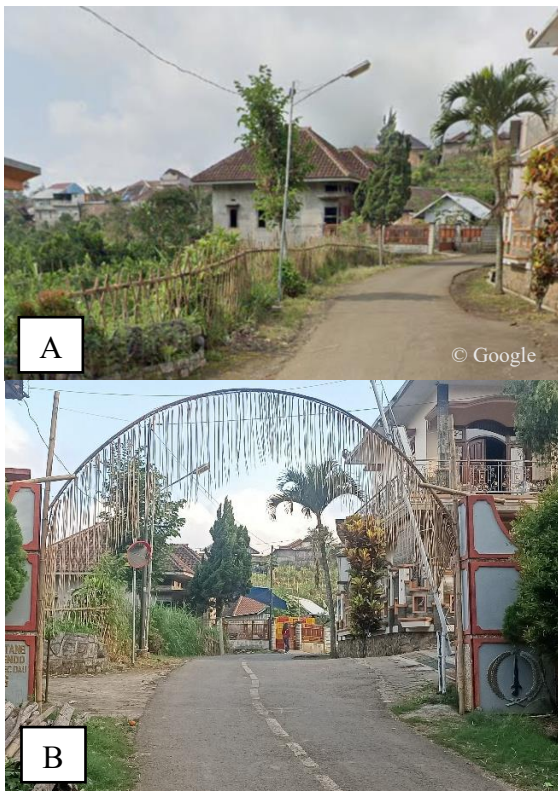
Gambar 3. Perbandingan Kondisi Pertigaan di Gapura Masuk Dusun Sumberbendo Sebelum Pemasangan Cermin Cembung (A) dan Sesudah Pemasangan Cermin Cembung (B)
