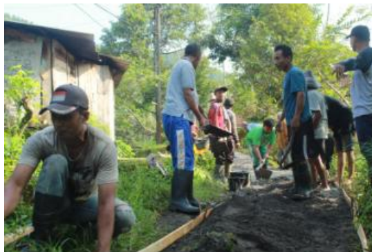
Gambar 2. Kerja bakti pengecoran jalan
